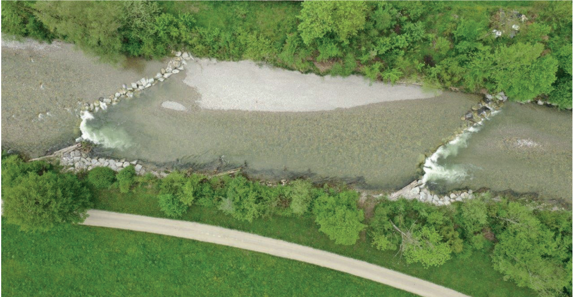
Blocksteinriegel in Hakenform schaffen tiefe Kolke, Emme, Gemeinde Eggwil (Bild: Karin Gafner, Fischereiinspektorat Kanton Bern).
