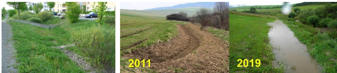
Abbildung 10: Versickerungssysteme. Links: Mulden-Rigolensystem im Siedlungsgebiet (Quelle: Wikipedia); rechts: Hangparallele Geländemulde im Landwirtschaftsgebiet (Fotos: Michal Kravcik)
