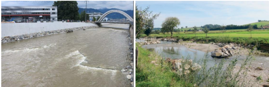
Abbildung 51: Überströmte Lenkbuhnen zur Induzierung eines Niederwassergerinnes in der Kleinen Emme LU (links, Foto: L. Meier). Umströmte Blockbuhnen in der Tulln / Niederösterreich (rechts; Foto: EZB TB Zauner)
