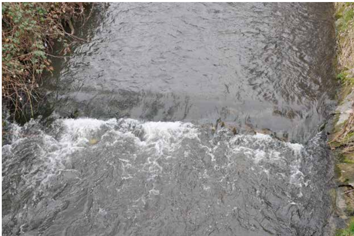
Abb. 2: Sohlschwelle am Aabach.
