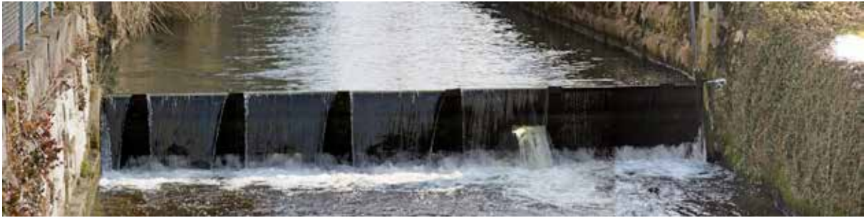
Abb. 6: Das Wehr des Kraftwerks Turicum Niederuster weist ein Loch auf, durch welches eine geringe Restwassermenge das Wehr durchströmt. Bei geringer Wasserführung ist das Wehr entgegen dem Bild nicht überströmt.
