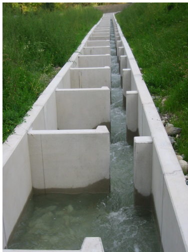
Abbildung 7: Schlitzpass
