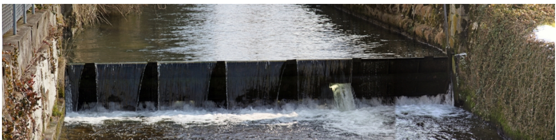
Abbildung 25: Ansicht der Wehrklappe des Kleinkraftwerkes auf dem Turicum-Areal, Thomas Gasser (2013)
